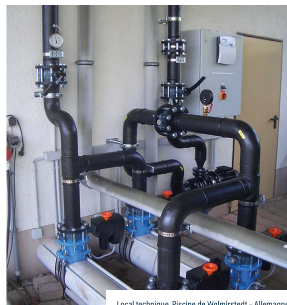
Local technique. Piscine de Wolmirstedt - Allemagne
